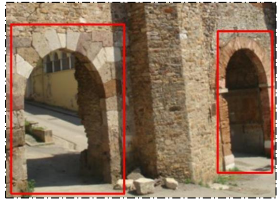
Figure.13. Porte refaite entièrement avec Nouveau type de pierre
