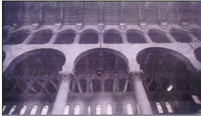
Fig II. 4: Vue intérieure de la mosquée de Damas. Source: H. Stierlin, 1979
