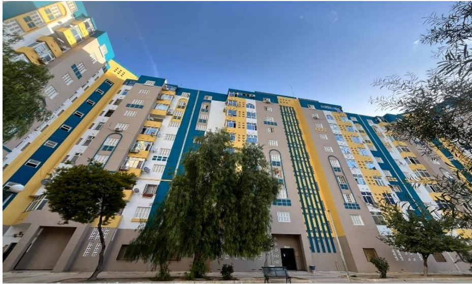
Fig V. 7: Traitement des façades des immeubles étudiés.
