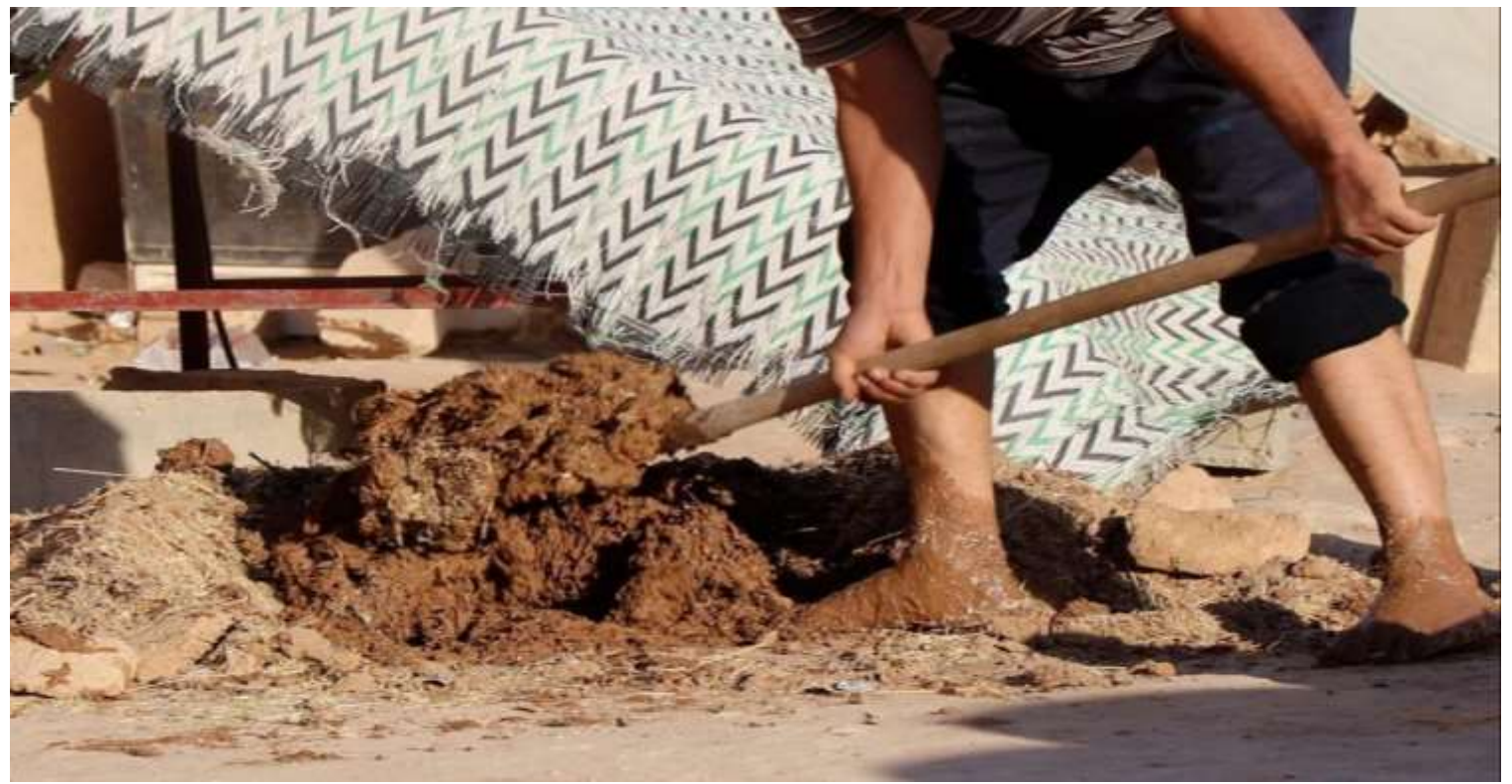
الصورة رقم 05: طريقة خلط التربة مع القش أو التبن بعد تجفيفه لإعداد الطوب الطيني، أنظر ص 73
