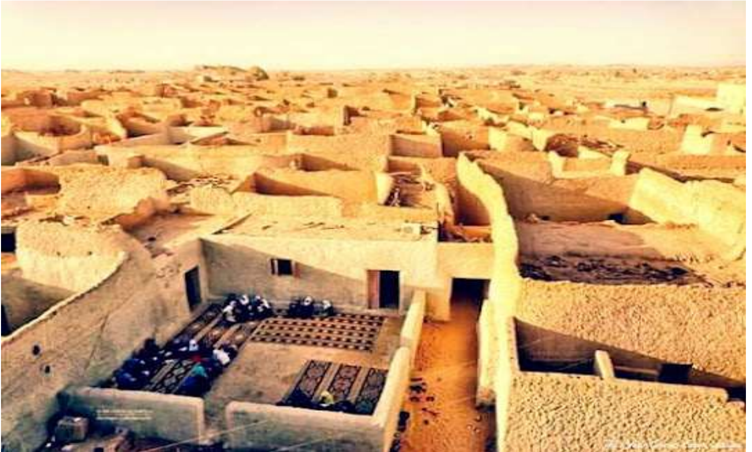
الصورة رقم 34: تجسد تصميم المباني الصحراوي والأزقة خصوصا الفناء ودوره في المسكن الصحراوي
