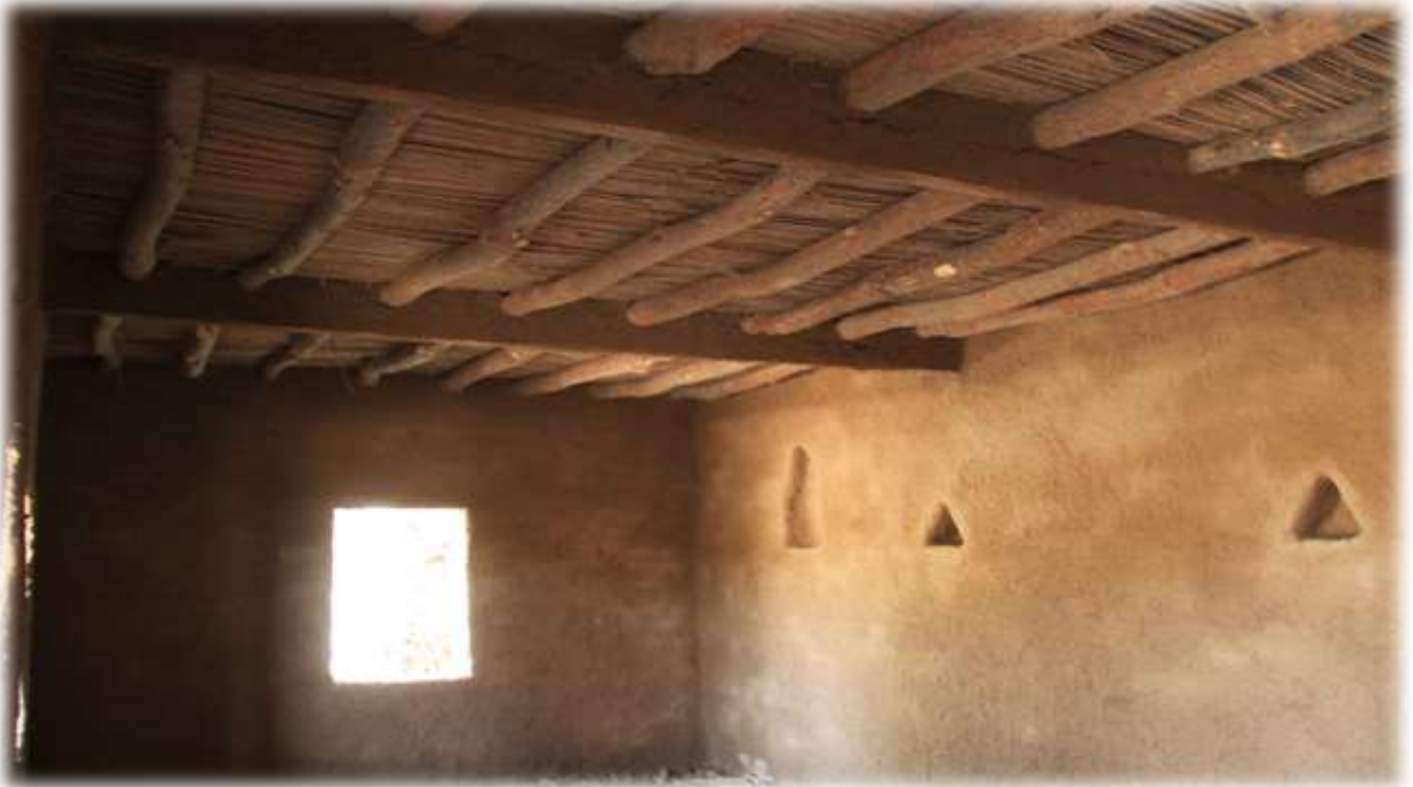
الصورة رقم 02: توضح إحدى غرف البناء الطيني بمواد أولية: الطين والخشب، أنظر ص 72
