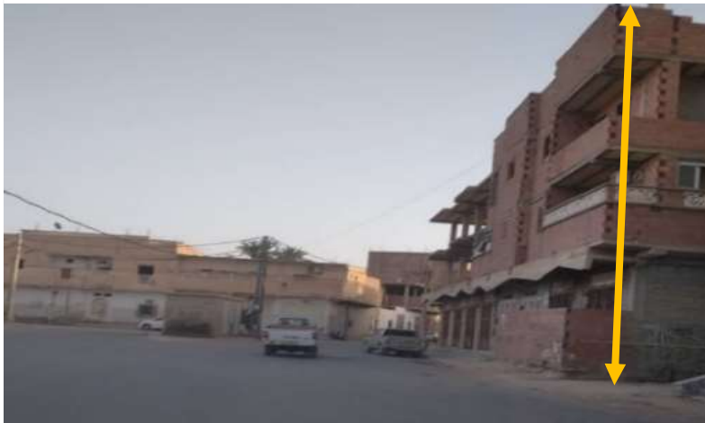
Photo 13: Non-respect des réglementations en matière de Hauteur des constructions
