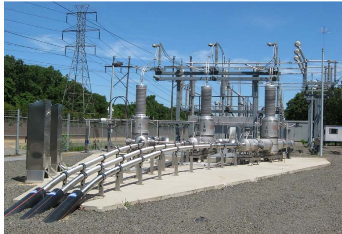
Figure I. 11. Câbles à supraconducteurs d'une liaison de 600 mètres en ville (New York).
