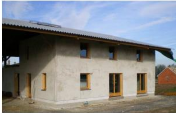
Figure I.6. Bâtiment construite en paille [22].
