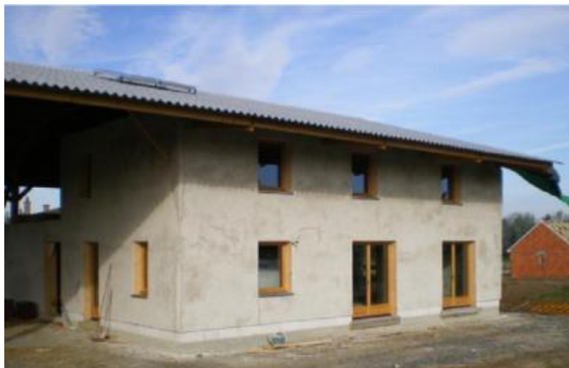
Figure I-6. Une maison construite en ballots de paille située à Voyennes dans le nord de la France [19]
