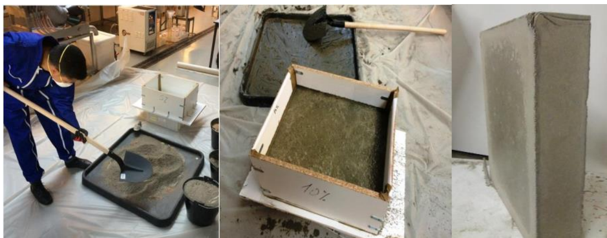
Figure III-2. Fabrication du mur en DPC
