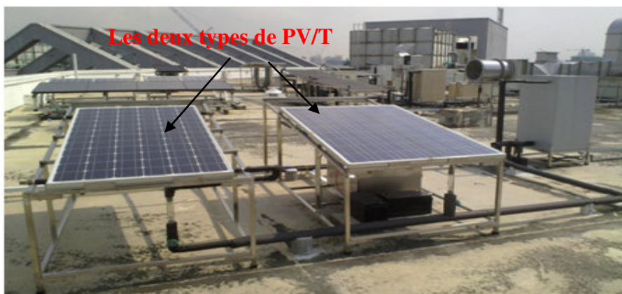
Figure 2.15 Photo des modèles PV/T réalisés
