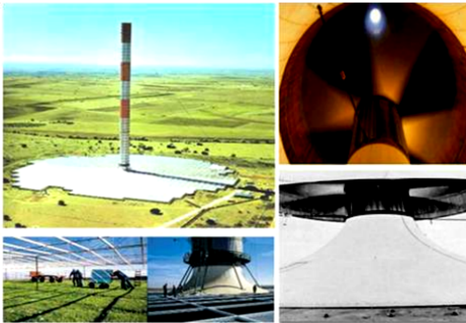
Fig. 2.6 : Photos de prototype de cheminée solaire installée à Manzanares (Espagne) [48].
