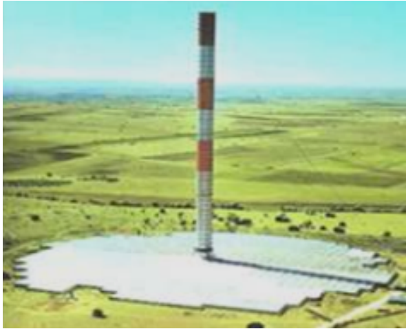
Fig. 2.1: Cheminée solaire installée à Manzanares(Espagne) [40].
