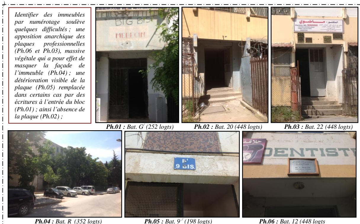
Figure 99 : Numérotage des blocs d'habitations entre absence, détérioration et confusion
