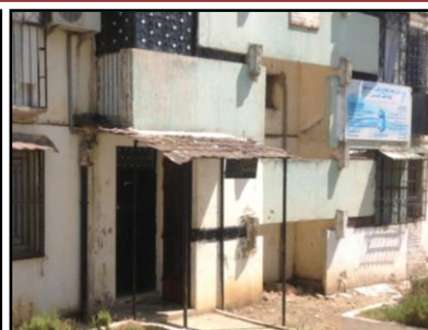
Ph.03 : Sur façade latérale (252 logts)
