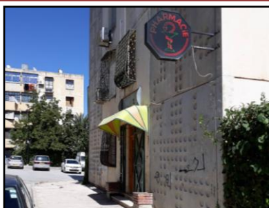
Ph.02 : Sur façade postérieure (448 logts)
