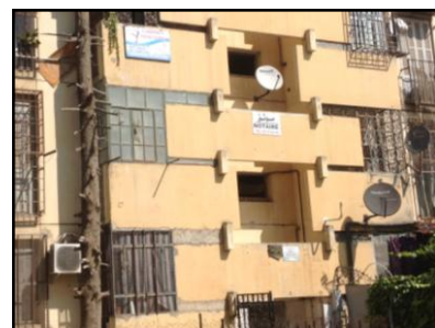
Ph.03 : sur la façade du bâtiment
