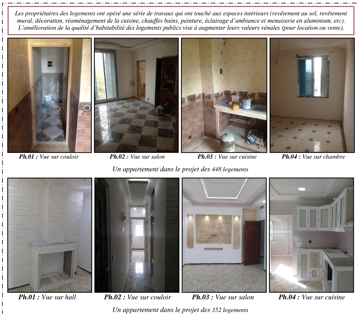
Figure 71 : Travaux d'aménagement et d'embellissement à l'intérieur des appartements
