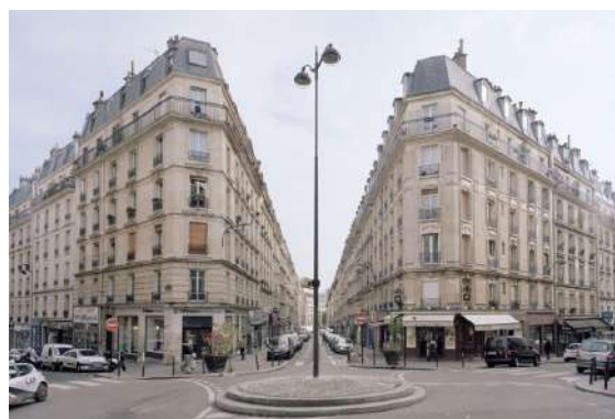
Figure 54: Exemple sur l'îlot haussmannien (©Cyrille Weiner, https://bit.ly/313A9wC )
